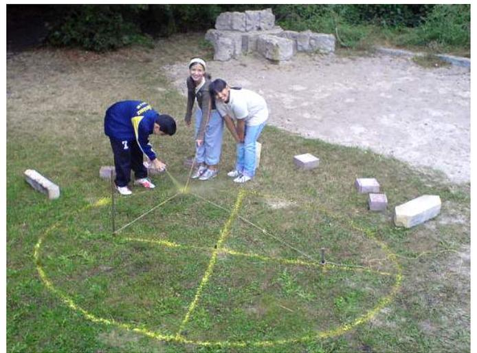
Als alles mit gelber Sprühfarbe auf grünem Rasen markiert war, konnten die fertigen Stundensteine eingesetzt werden. Abschließend wurde der volle Umfang der Ellipse mit Kleinpflaster gestaltet.
